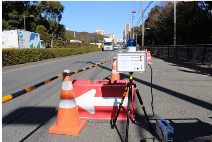
写真-3 ドレミ現場使用状況
