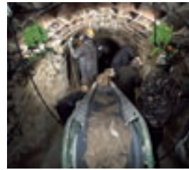
土木工事(とう道)
