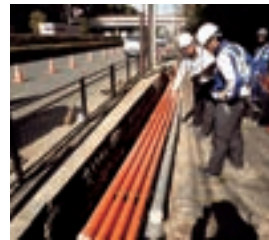
電線地中化工事
