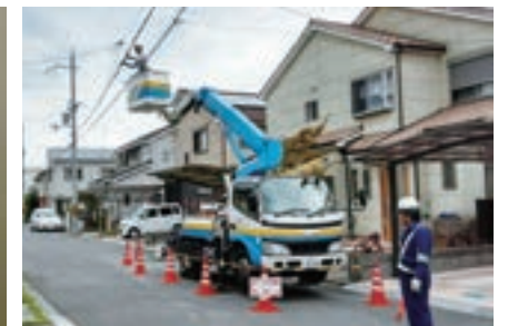
ケーブル引込作業
