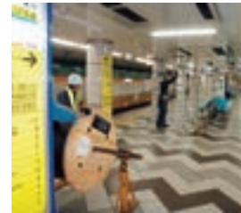
駅構内不感地対策工事
