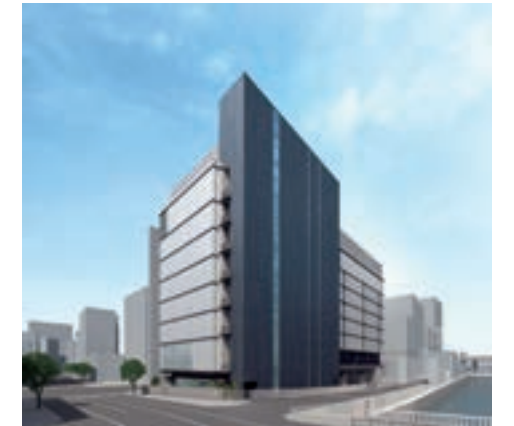
大阪第1データセンター(イメージ)
